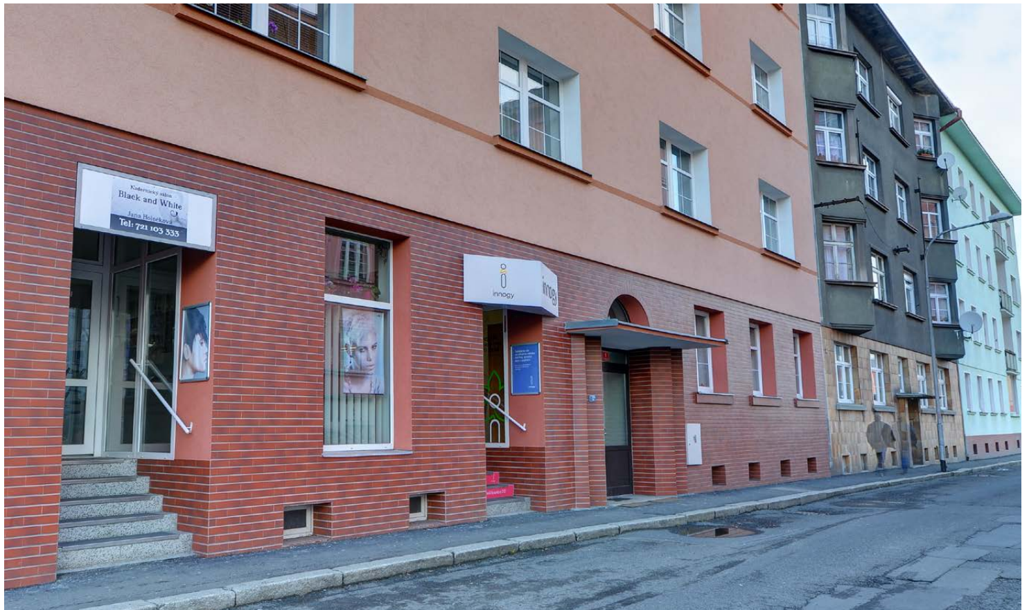
obr. 1 Pohled na pobočku
