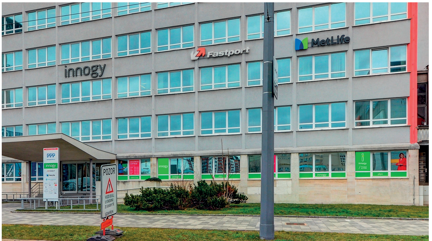
obr. 01 Pohled na pobočku
