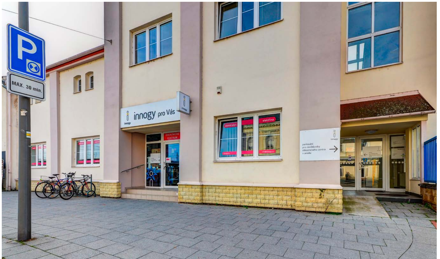
obr. 1 Pohled na pobočku
