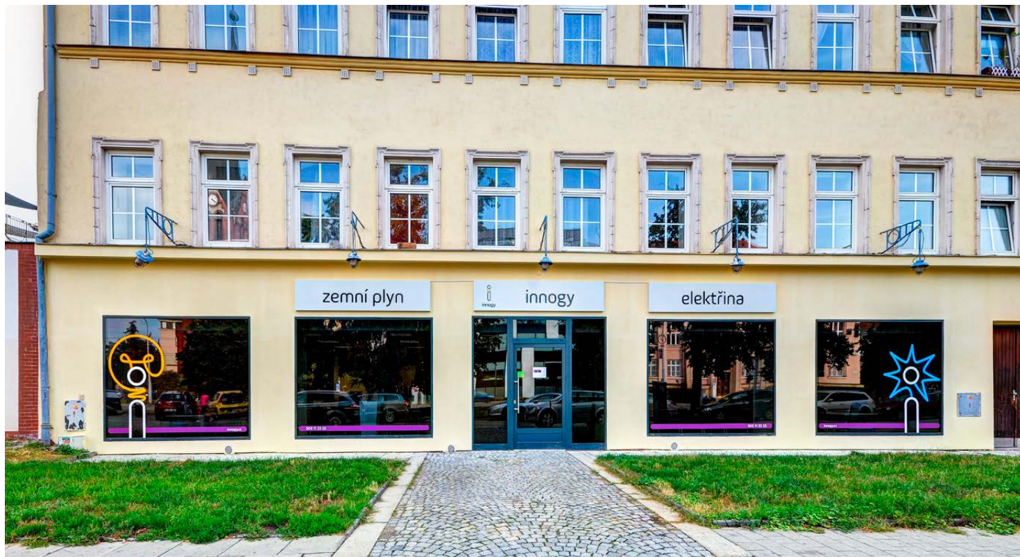
obr. 01 Pohled na pobočku
