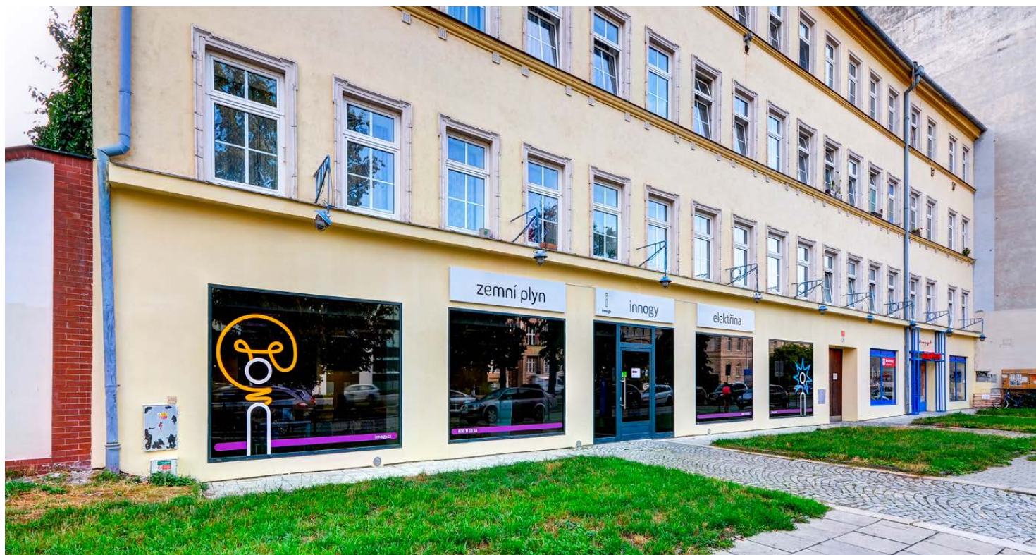
obr. 2 Pohled na pobočku
