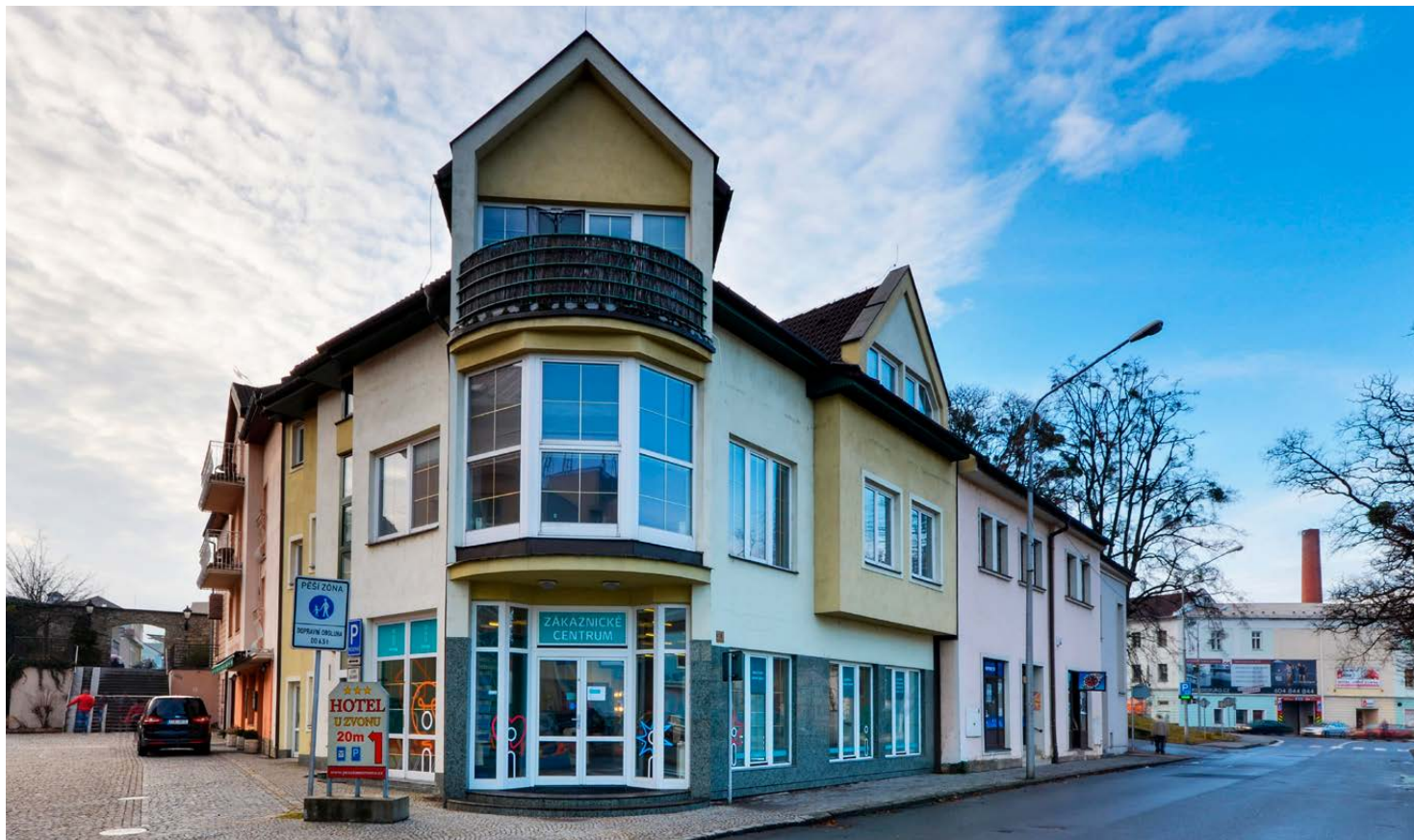
obr. 1 Pohled na pobočku
