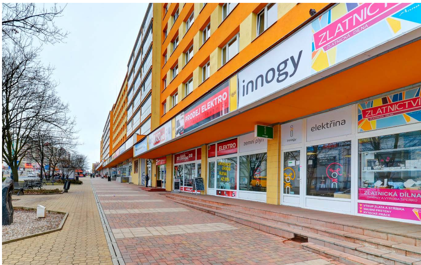
obr. 1 Pohled na pobočku
