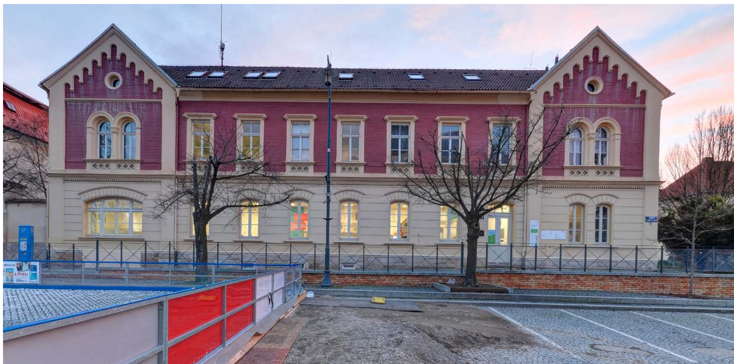
obr. 1 Pohled na pobočku
