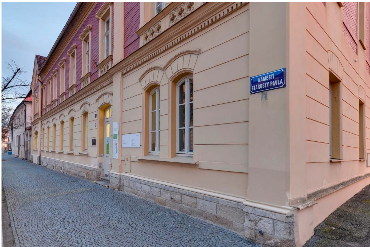
obr. 2 Pohled na pobočku
