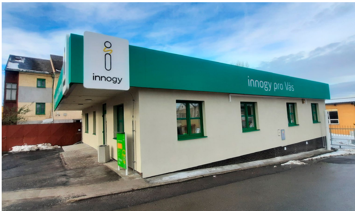
obr. 3 Pohled na pobočku
