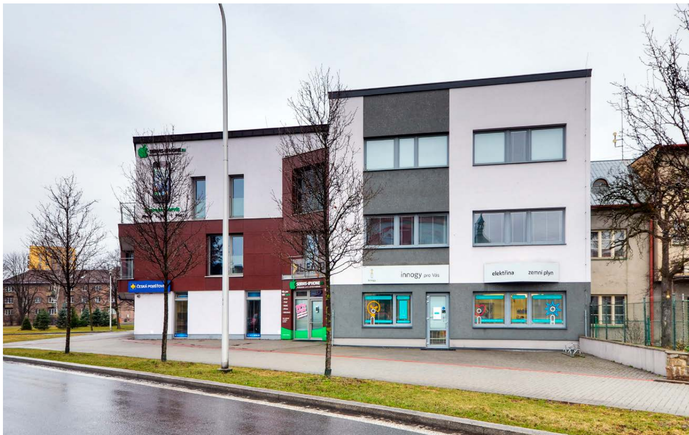
obr. 1 Pohled na pobočku
