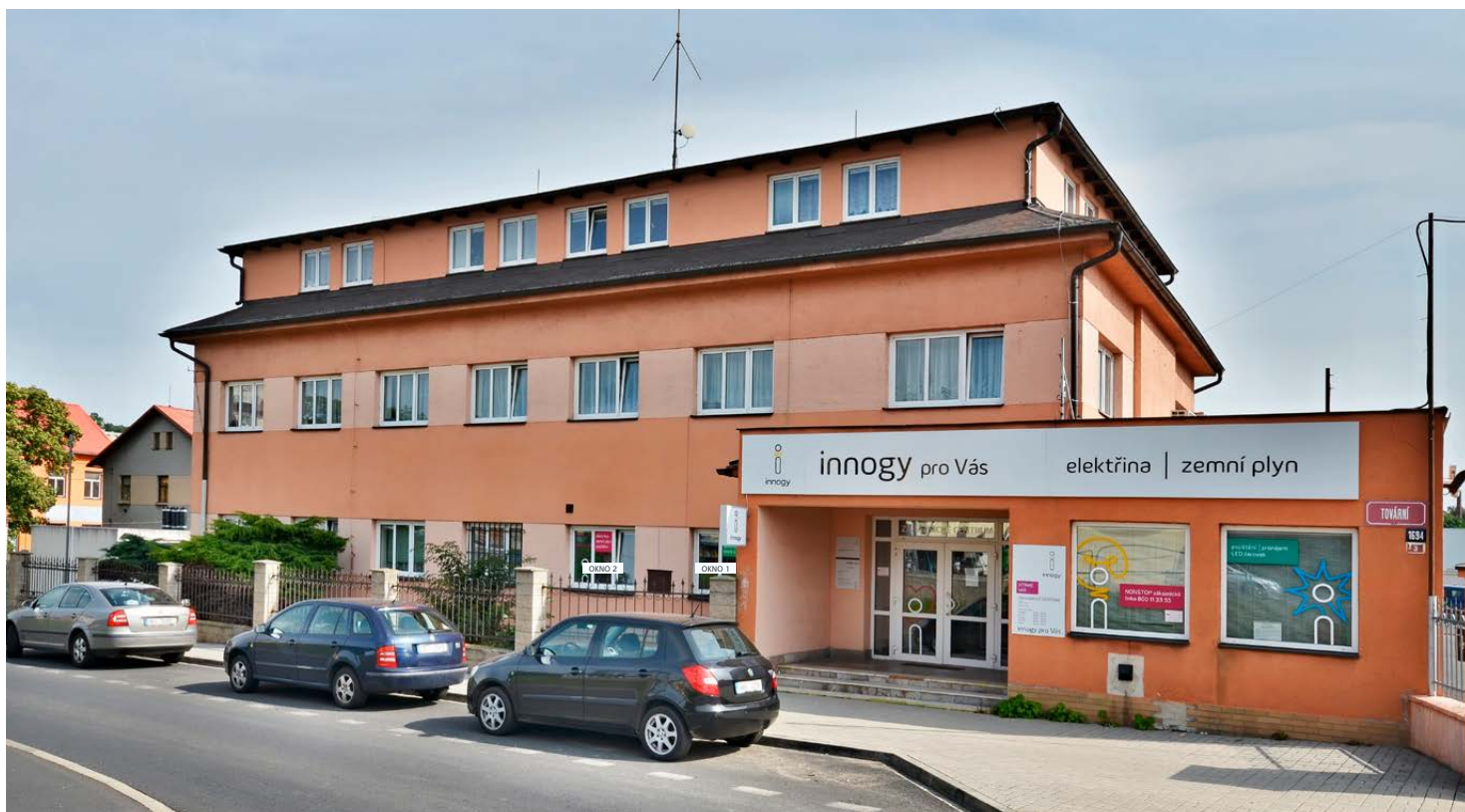
obr. 2 Pohled na pobočku
