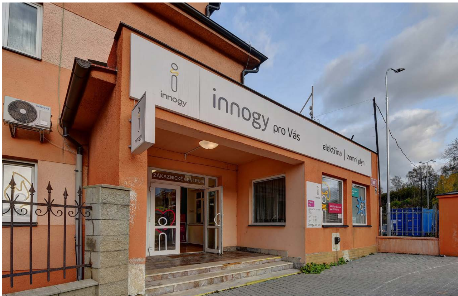
obr. 1 Pohled na pobočku
