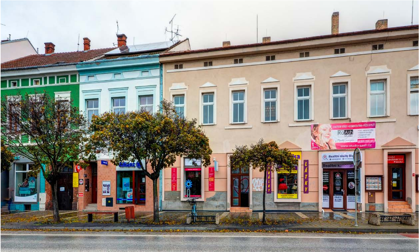
obr. 1 Pohled na pobočku
